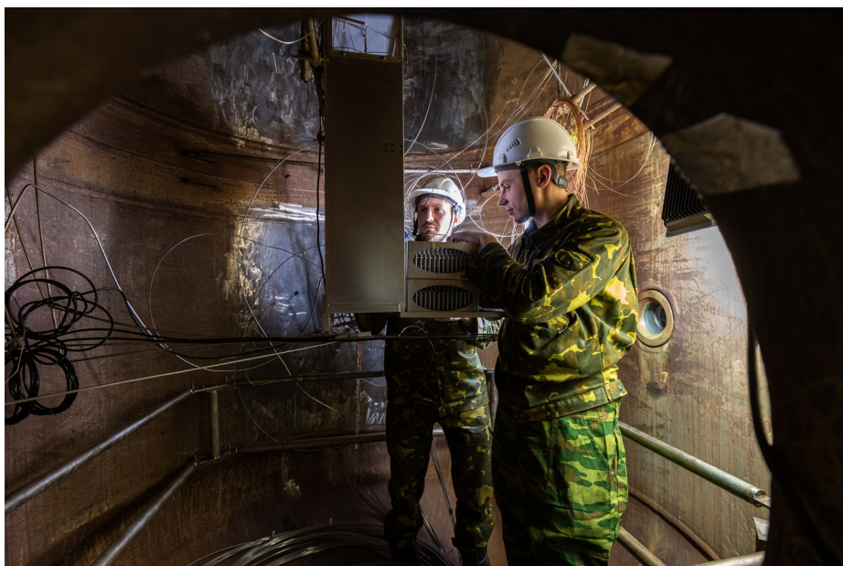
Сотрудники НИО-4 М.А. Томилов и А.А. Тараканов осуществляют подготовку испытаний рекомбинатора водорода внутри экспериментальной установки БМ-П
